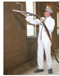
Enlucido de barro proyectado por pistola en interiores
