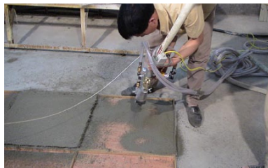
Fabricación de placas de hormigón vitrificado
