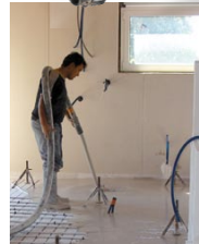
Pavimento continuo con la S 5 EV
