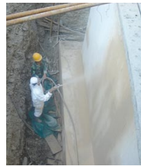
Revestimiento de cimientos de hormigón
